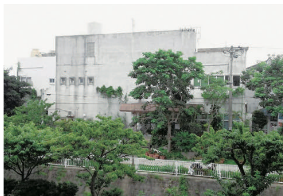
かつて那覇琉米文化会館だった那覇市中央公民館・図書館
